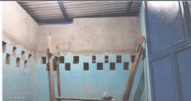
Foto 2: LEVANTAMIENTO DE MURO QUE DIVIDE AULAS PARA MAYOR SEGURIDAD DE EQUIPO DE LABORATORIO.
