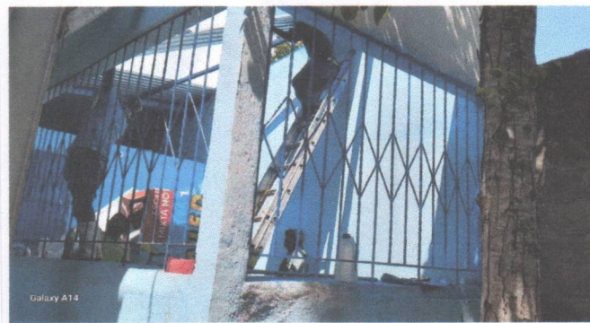
Foto 6: COMPRA DE DOS BALCONES Y PUERTA DE METAL PARA AULA.
